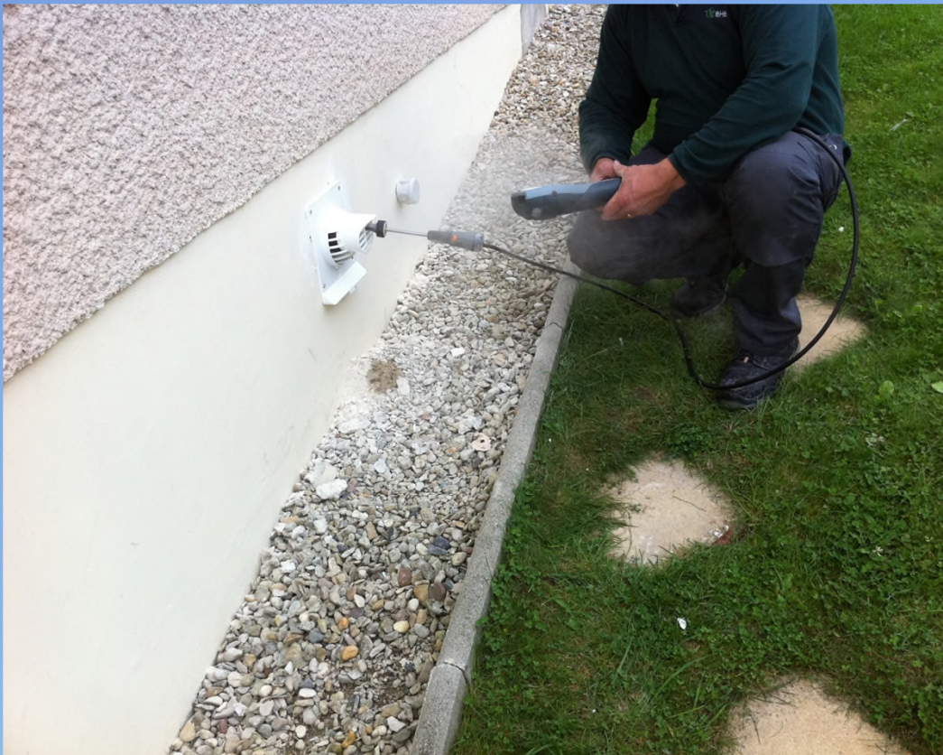
Vérification de la bonne combustion
